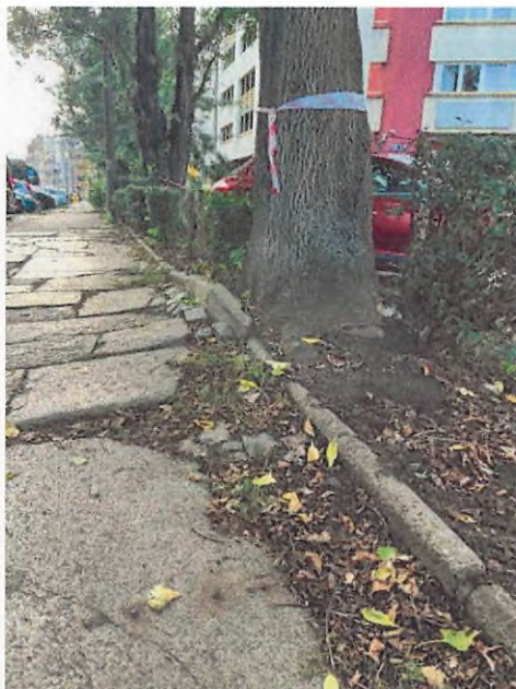
fot. 13 – niszczona nawierzchnia przez korzenie bożodrzewu nr inw. 28
